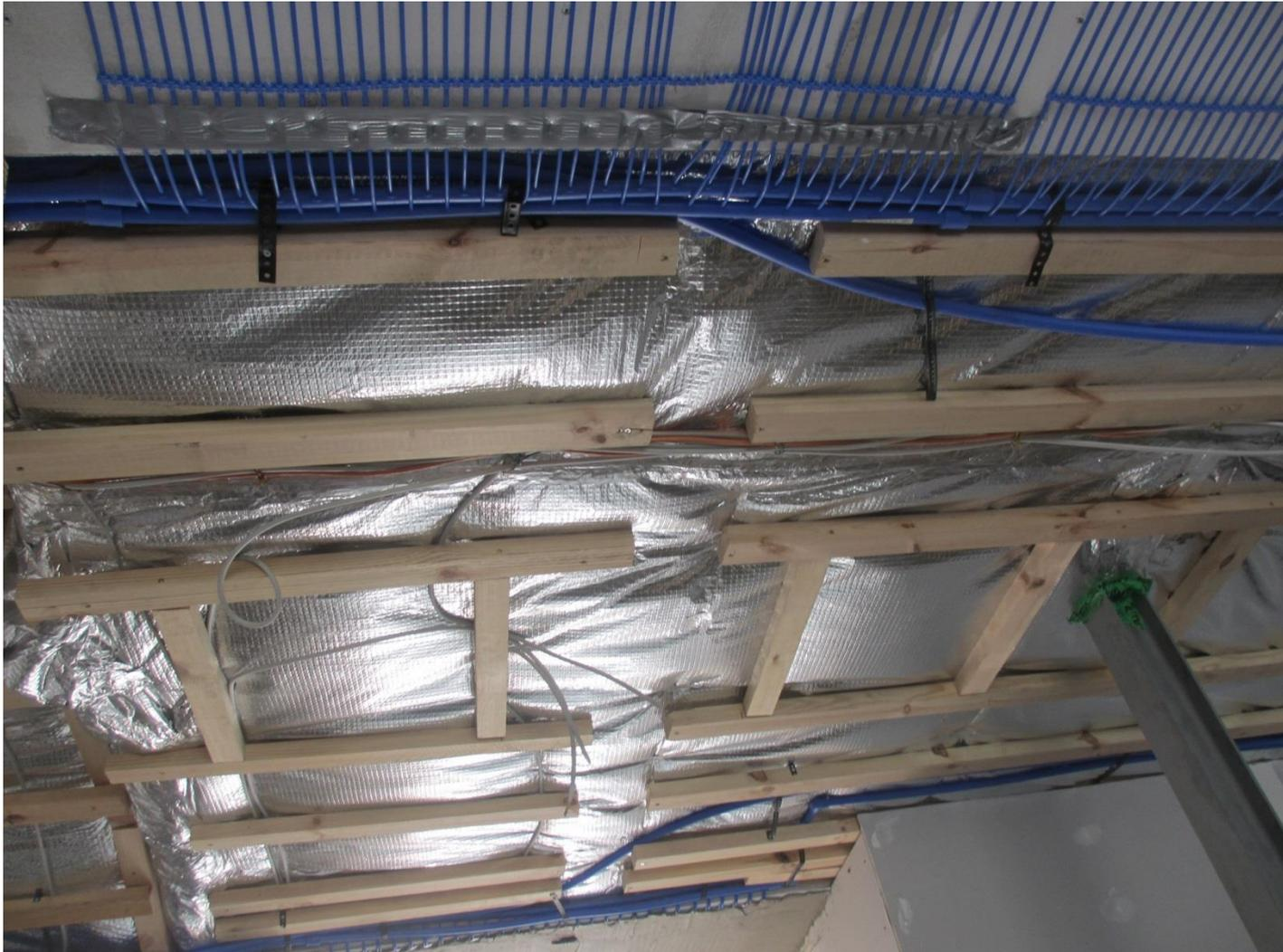
Falsch: durchhängende Isolierung, Reflexion eingeschränkt, Dachgeschossaufbau in Berlin
